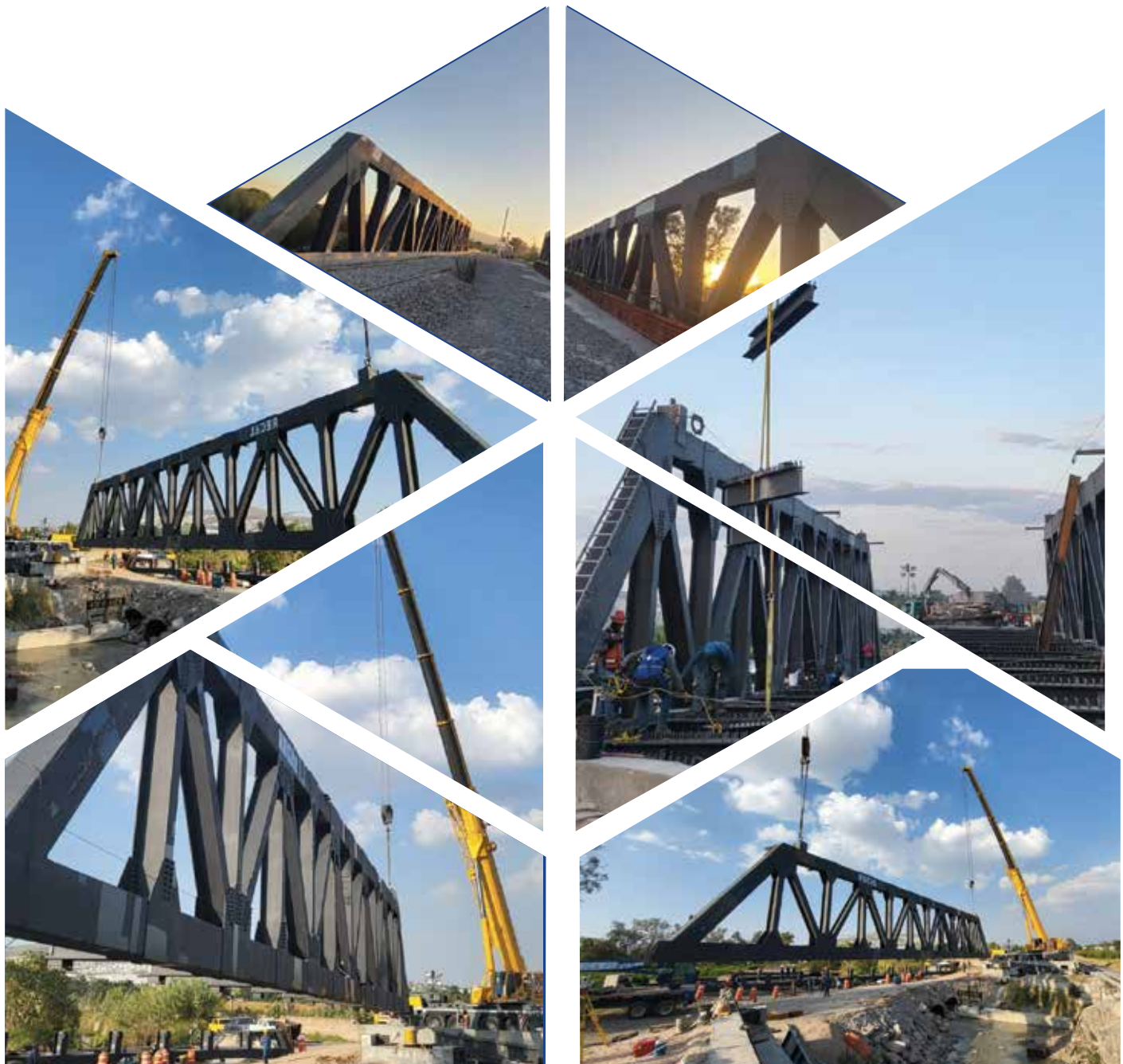
Puente San Pedro
